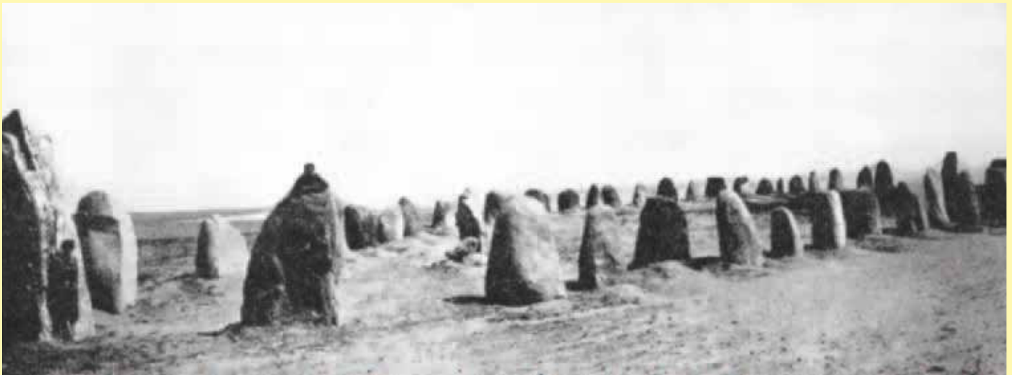
Fig 29. Ales stenar efter restaureringen 1916. Den sydöstra stävstenen lutar något åt höger i bild vilket senare rättades till. Foto Axel Carlborn 1917.
