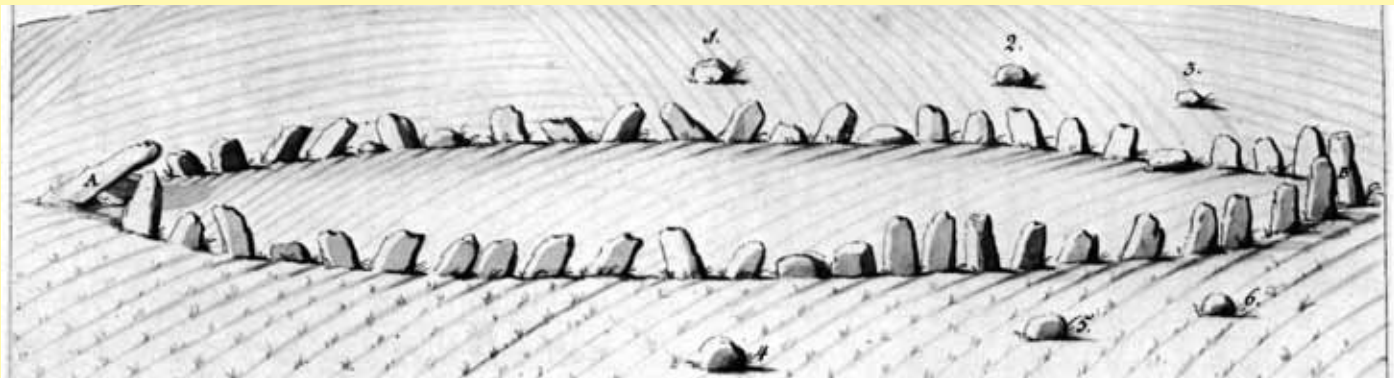
Fig 12. C.G.G Hilfelings teckning från 1777 visar att stävstenen halvligger över den fallna sidostenen i samma läge som 1914. Någon förändring av dessa positioner har uppenbarligen inte skett före restaureringen 1916, dvs. på 138 år. Den så kallade altarstenen är till synes översandad på Hilfelings teckning. (Hilfelings journal. Kungliga Biblioteket, Köpenhamn).
